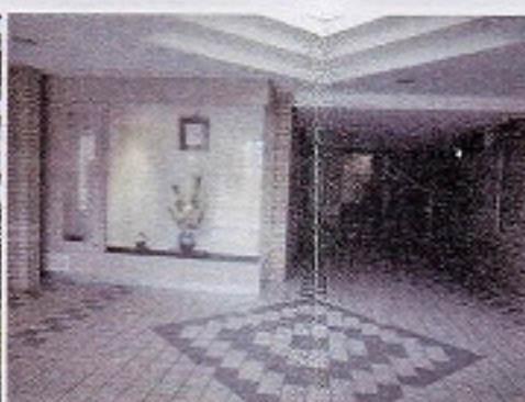
エントランス、ギャラリーの改修
