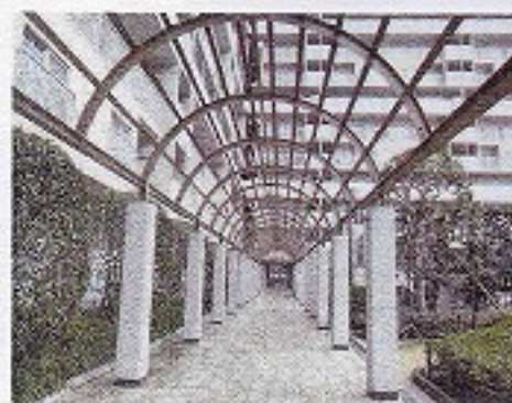
パーゴラ、外構の改修
